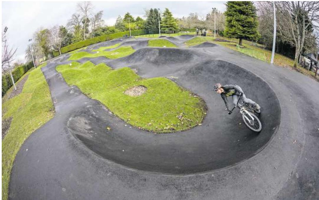
Der Pumptrack wird überhöhte Kurven, Bodenwellen und einen Asphaltbelag erhalten.
